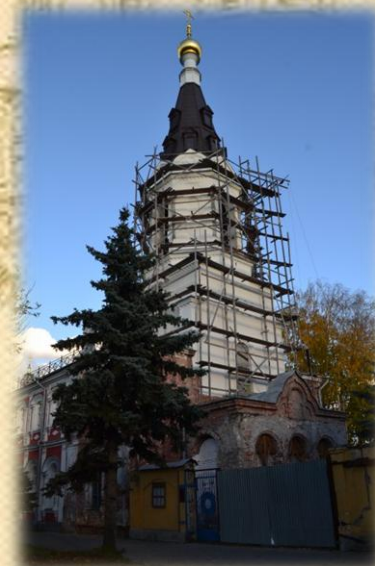
Установка шатра колокольни
